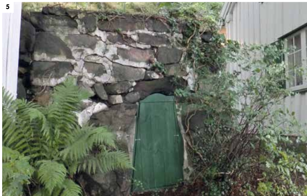
1: Uthus/utedo (Ny Hellesund) 2: Uthus i bruk som annek (Kirkehamn) 3: Bryggerhus (Kirkehamn) 4: Uthus med garasje (Loshavn) 5: Potetkjeller (Kirkehamn)
