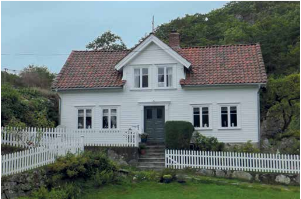
Osmundstø. Kirkehamn. Eksempel på et godt vedlikeholdt hus med i hovedsak opprinnelige bygningsdeler
