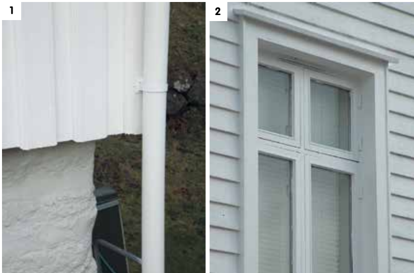
1: Stort sprang mellom veggliv og grunnmur etter utvendig etterisolering av yttervegg 2: Dyp vindusnisje etter utvendig isolering av yttervegg
