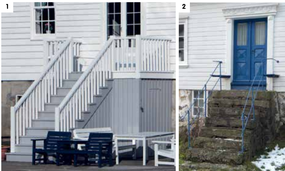
1: Tretrapp (Ny Hellesund) 2: Ettløps steintrapp med sittebenker (Veisdal, Hidra)
